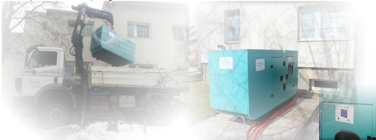
Montaža agregata za energetska neovisnost – donacija Eurpske unije
